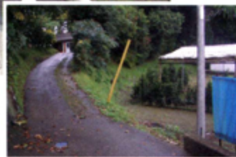
狭い進入路をリフォームして拡張した例。アスファルト舗装を施して車の出入りをしやすくした(写真:上は本誌、下は郷土開発)
