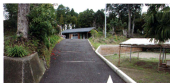
狭い進入路をリフォームして拡張した例。アスファルト舗装を施して車の出入りをしやすくした(写真:上は本誌、下は郷土開発)
